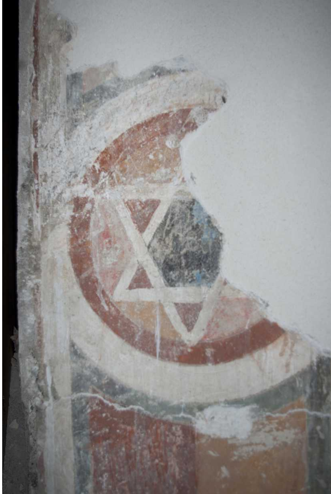
Freska ostenia východného okna presbytéria po odkryve
