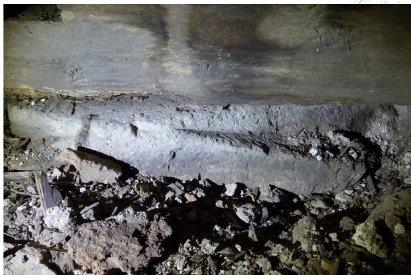
2. Rybník, jeden zo sekundárne využitých kamenných článkov, tvoriacich po ďalšom opracovaní novú korunnú rímsu muriva presbytéria. Foto: R. Erdélyi, 2014.
