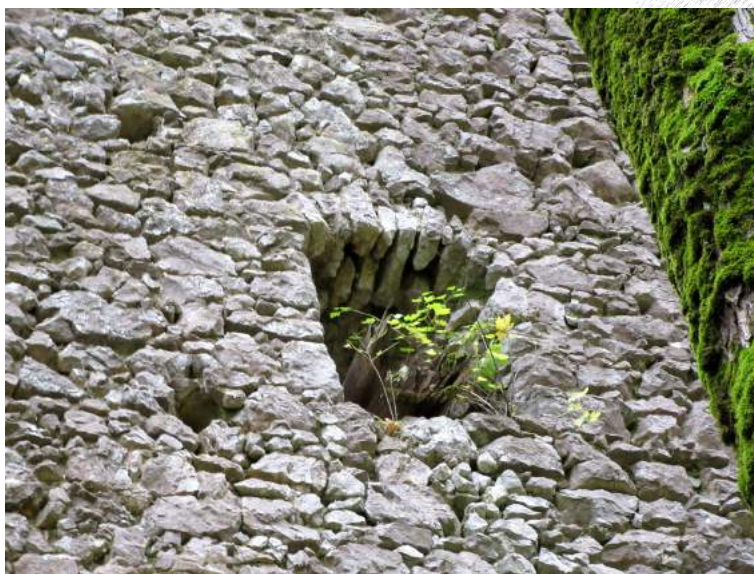
5. Severozápadný úsek hradby, detail strielne. Foto: M. Šimkovic, 2015.
