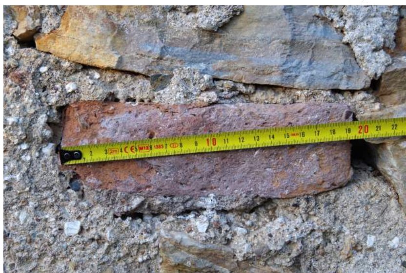
3. Rybník, jedna zo sekundárne využitých tehál zo staršieho objektu (s kusom pôvodnej ložnej malty) v spodnej časti muriva súčasného kostola – šírkový rozmer. Foto: R. Erdélyi, 2014.
