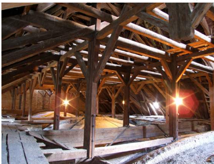
28. Rožňava, ev. a. v. kostol. Pohľad do krovu s ležatými a stojatými stolicami. Foto: L. Suchý, 2016.
