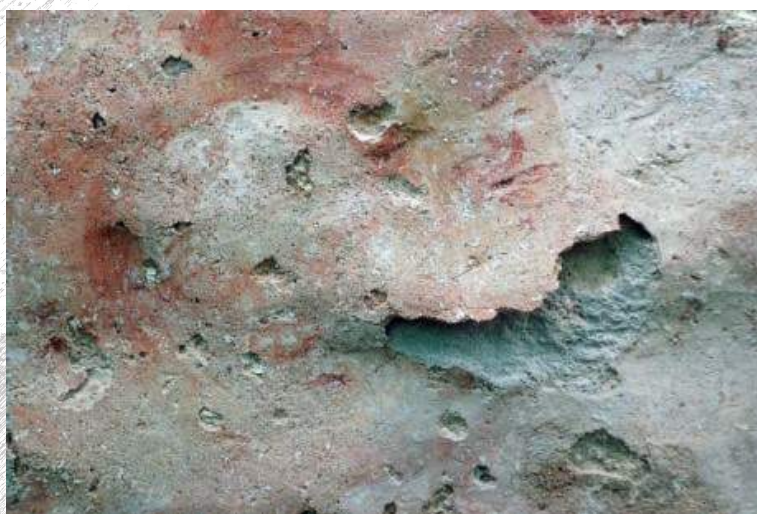
8. Odstránenie tmelu a príprava na vyrovanie a prichytenie k podkladu. Foto: restau.art, 2015.
