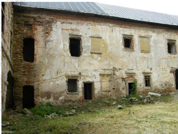
4. Dvorová fasáda juhozápadného krídla s nálezmi odtlačkov asanovanej pavlače. Foto: L. Fillová, 2014.
