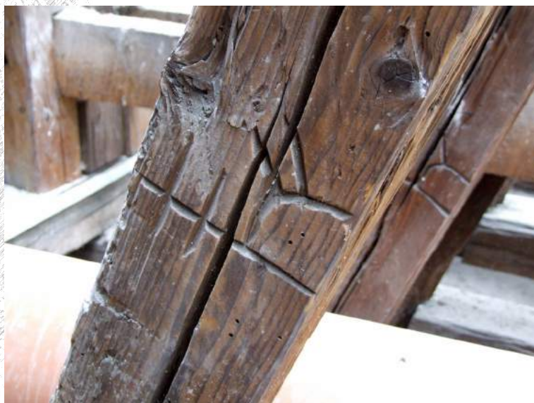
2. Liptovský Mikuláš-Okoličné, kostol františkánskeho kláštora. Tesárska značka v krove nad loďou. Foto: L. Suchý, 2010.
