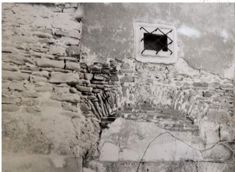
12 Kamenný odlahčovací oblúk nad zamurovanou bránou, spomínanou v súvislosti so zaklenutím poschodia v západnom ambite v roku 1695. Zdroj: URBANOVÁ 1982, ref. 14.
