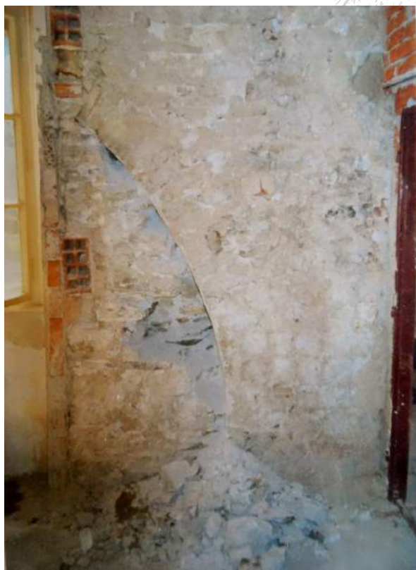
◀◀ 13. Stredoveký osvetľovací otvor nad barokovým portálom vstupu. Foto: N. Urbanová, 2015.
