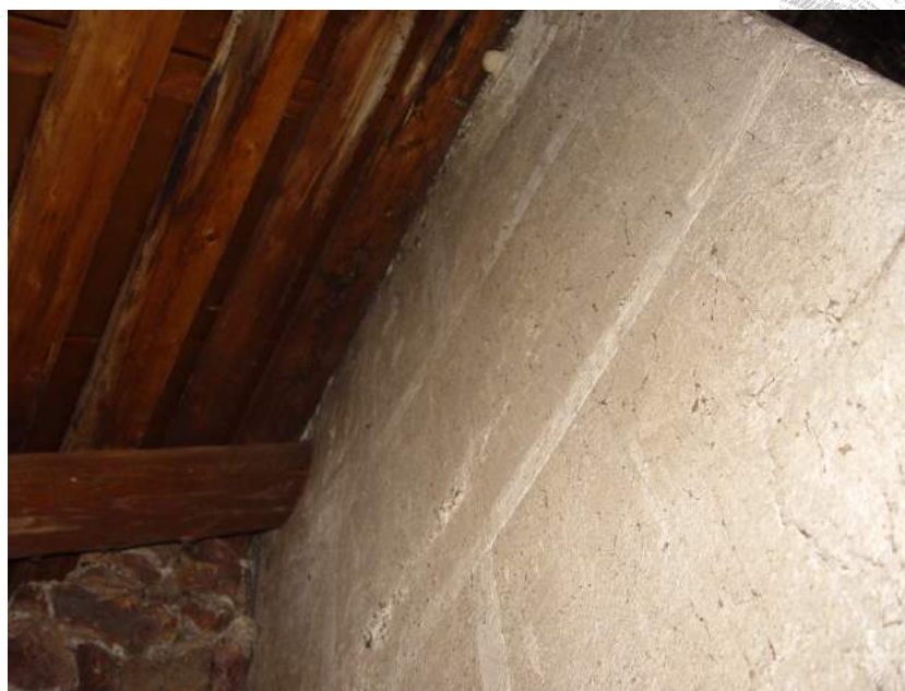
14. Iluzívne kvádrovanie v omietke pôvodnej exteriérovej fasády veže po jej znovupostavení pred polovicou 18. storočia. Foto: M. Janovská, 2014.
