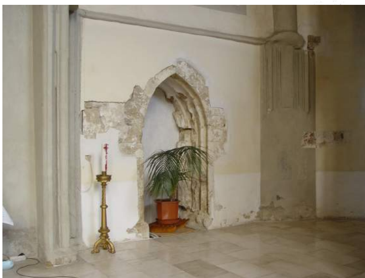
4. Pohľad na zamurovaný gotický portál z presbytéria do sakristie objavený sondou počas výskumu a následne odkrytý
