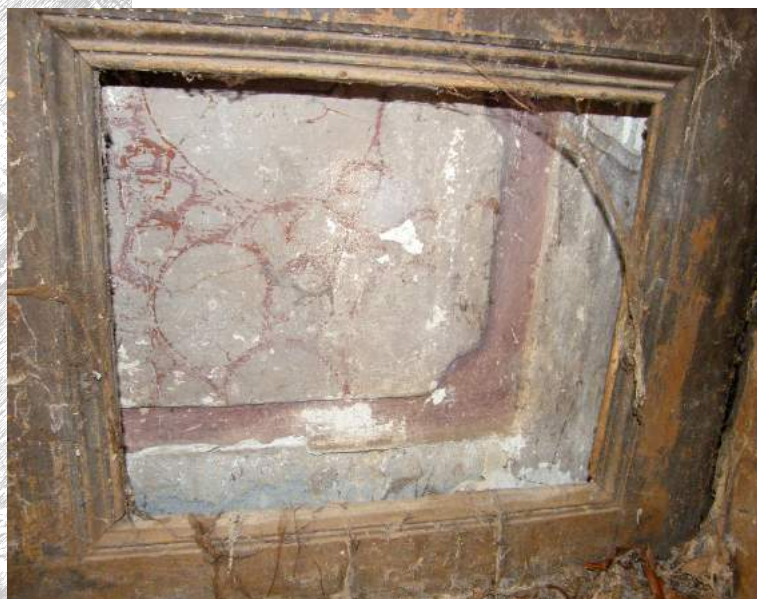
12. Detail neskorobarokovej výzdoby sokla na 2. nadzemnom podlaží severovýchodného krídla. Foto: L. Fillová, 2015.
