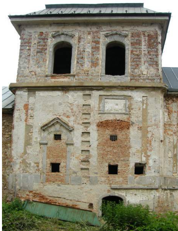
13. Vežová stavba v severovýchodnom krídle, prestavaná na sýpku. Foto: L. Fillová, 2014.
