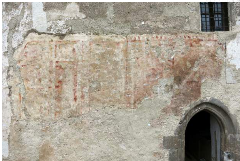
10. Západná časť výmalieb južnej fasády. Foto: restau.art, 2015.
