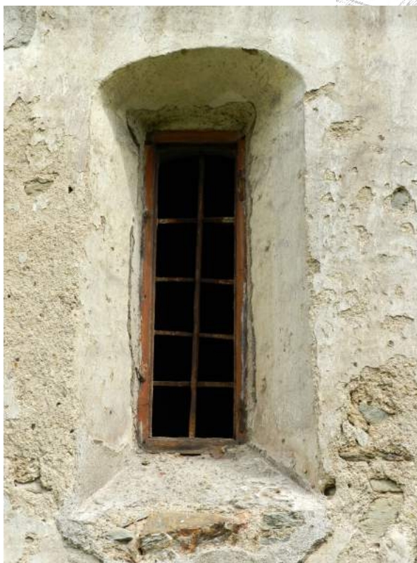
15. Henckovce. Kostol Všetkých svätých. Zachované primárne okno v prvej západnej osi na južnej fasáde. Foto: M. Kalinová, 2016.
