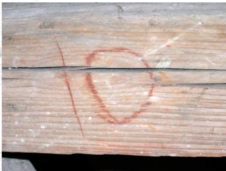
3. Spišská Kapitula, Kaplnka Zápoľských. Tesárska značka 10 v krove nad kaplnkou. Foto: L. Suchý, 2003.
