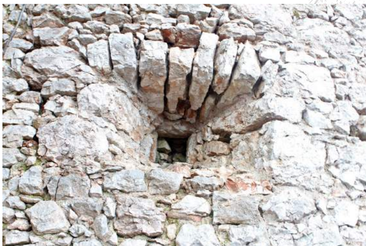
7. Východná bašta, detail strielne.
